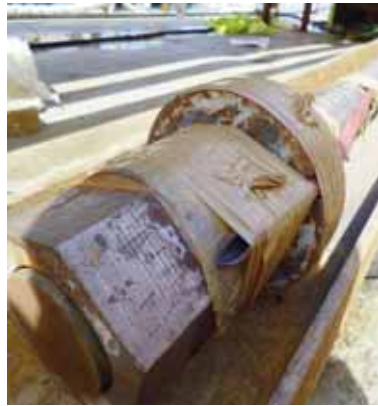
Particolare barra d' ancoraggio Anchor bar detail
