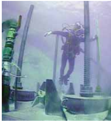
Riempimento cassone Anchor block filling
