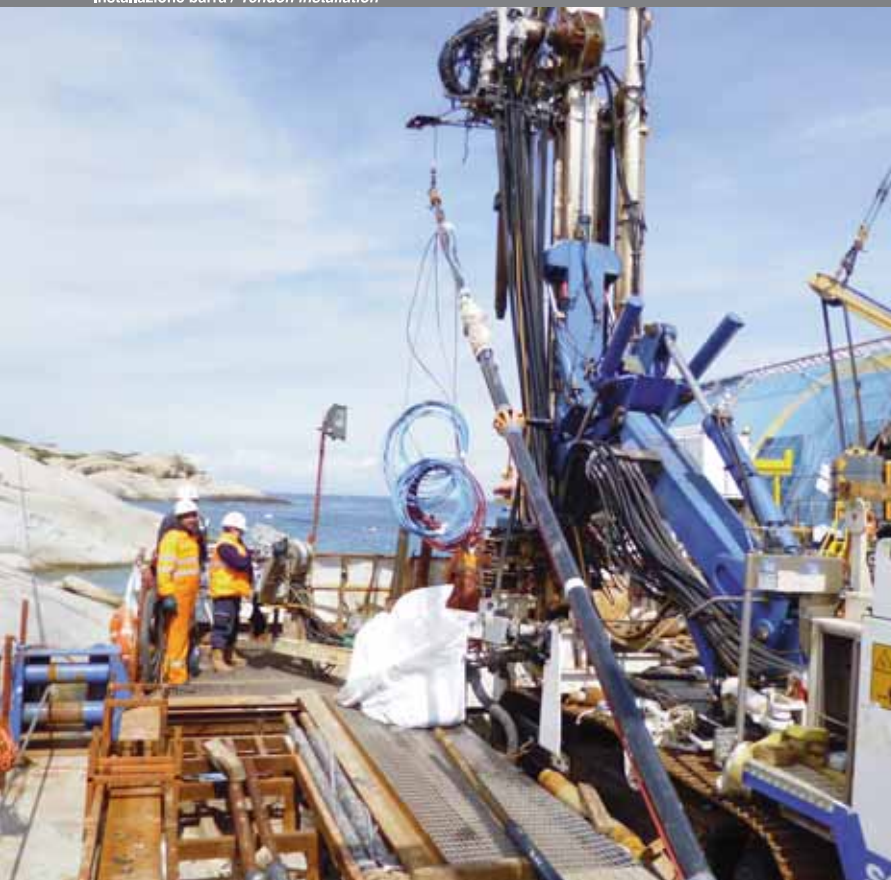
Installazione barra / Tendon installation
