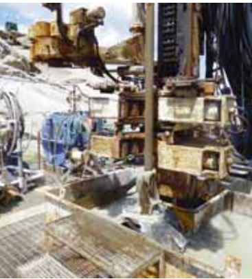
Perforazioni con martello fondo foro DTH drilling
